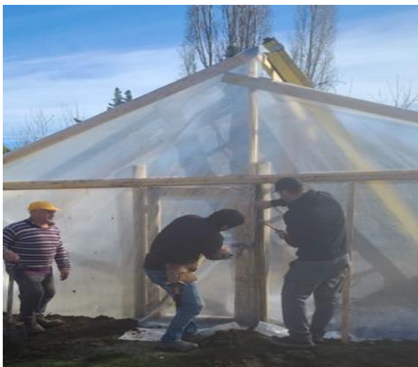
Construcción de invernadero
