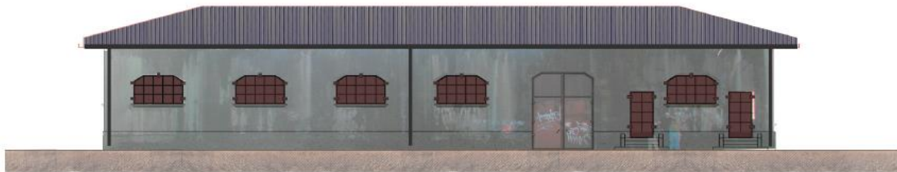
FACHADA POSTERIOR - SURPONIENTE
